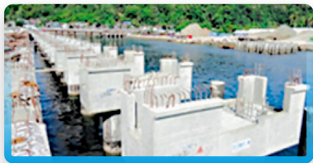
PRECAST PILE CAP
