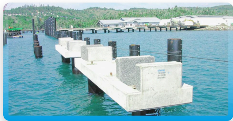
PRECAST PILE CAP
