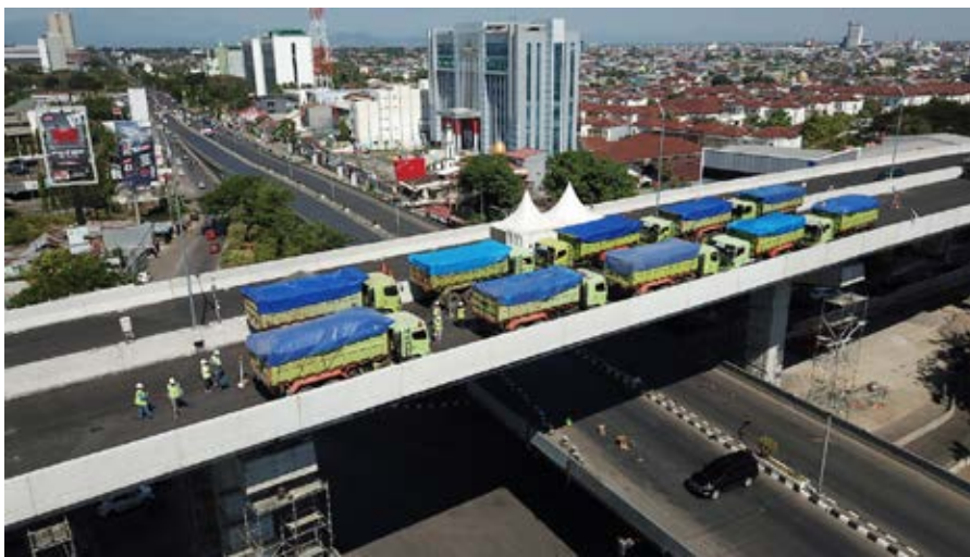
● Loading test struktur jembatan Jalan Layang Tol A.P. Pettarani yang terintegrasi dengan WTON SHMS
